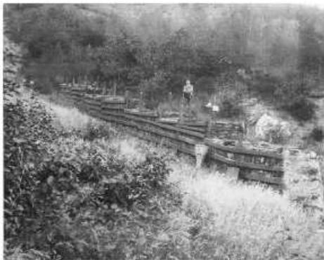
▲ 15 - Val Crana, verso il 1900: dettaglio sulla spalla di 35 ml costruita con una tecnica particolare per compensare la carenza di blocchi. Oggi si trovano solo i sassi e qualche piantone di legno.
