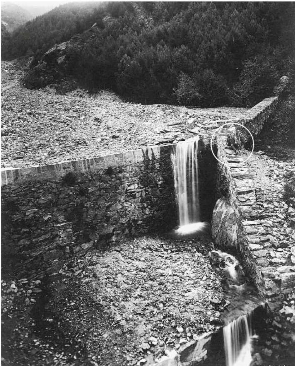
L'attività di premunizione in alveo mediante la costruzione di briglie, anche di dimensioni considerevoli fu molto intensa nei primi anni. I primi interventi dovevano prioritariamente limitare l'attività d'erosione dei vari corsi d'acqua per permettere, in seguito, il risanamento dei versanti.
