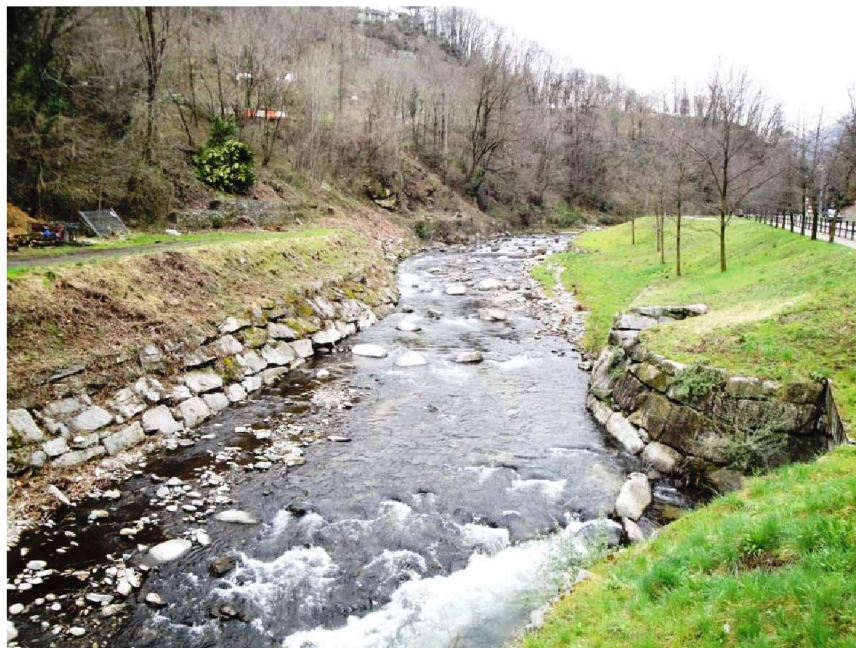
FIUME CASSARATE nei pressi del Ponte di Valle – PRIMA DEI LAVORI
