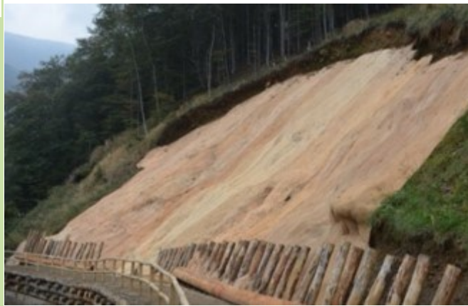
Esempio di risanamento con stuoie in lana di legno
